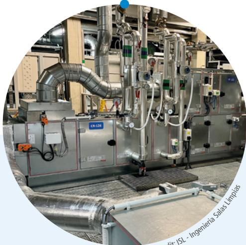
Costante monitoraggio del tenore di CO<sub>2</sub> dell'aria in un condotto di ventilazione all'uscita di un'unità di trattamento aria.
