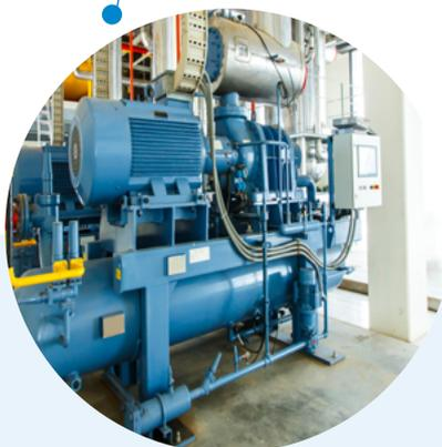
Mettere in servizio o fare manutenzione ad un sistema di refrigerazione, controllare la tenuta del circuito del refrigerante, riempire il gas e controllare simultaneamente la pressione differenziale e le temperature di sottoraffreddamento/surriscaldamento.
