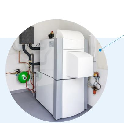
Misurare la pressione alla valvola di ingresso del gas, il tiraggio della caldaia e la pressione differenziale attraverso un filtro o qualsiasi altra parte del sistema di combustione per verificare sicurezza ed efficienza.
