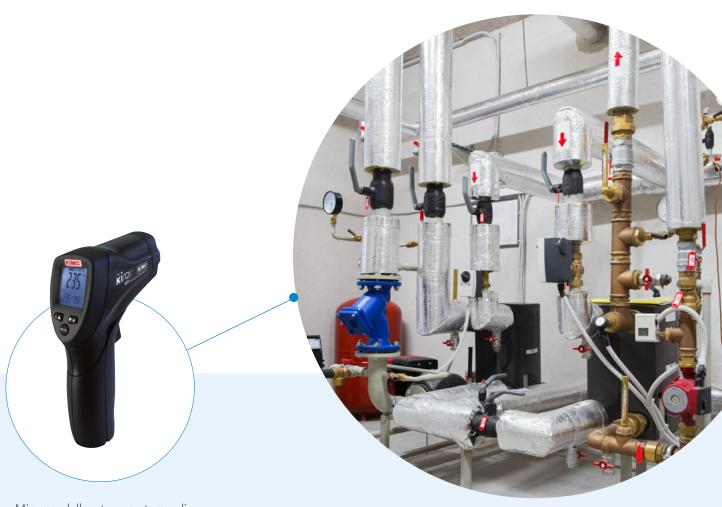
Misura della temperatura di mandata e di ritorno dell'acqua di un sistema di distribuzione del calore.
