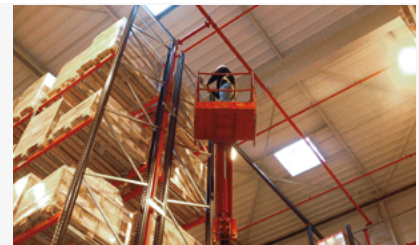
Pose d'enregistreurs dans le cadre d'une cartographie biannuelle en entrepôt de grand volume.
