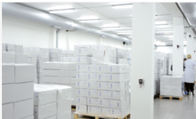
Cartographier un entrepôt de médicaments sous la norme FD X15-140 Mai 2013 en température et en humidité relative à 20^{\circ} \pm 5^{\circ}\text{C}
