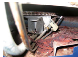
Corrosione o arrugginimento dell'ugello del bruciatore
