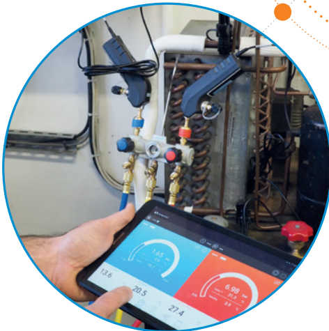
CONTROL CON MANIFOLD COMBINADO SI-RM13
