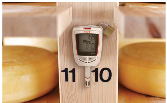
Contrôle en humidité relative et température en cave d'affinage, assuré par un KT220 fixé sur platine de fixation et sécurisé par un cadenas dans le cadre d'une cartographie.
